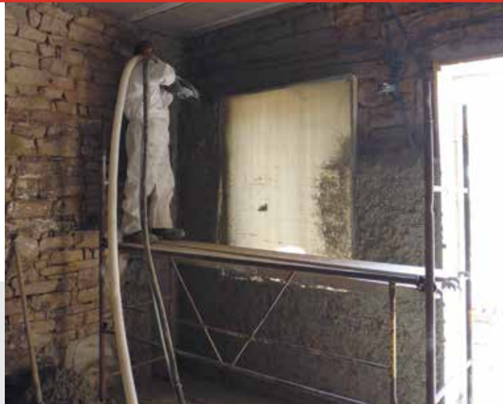
L'isolation des murs en chaux-chanvre : la garantie d'un isolant respectueux des échanges hygrométriques des murs en pierre.
