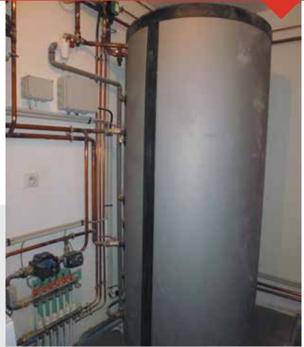
Le ballon tampon de 1000 litres intègre le ballon d'eau chaude au bain-marie.
