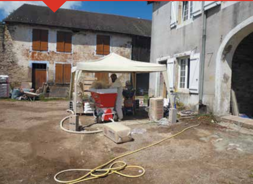
L'isolation des murs en chaux-chanvre : la garantie d'un isolant respectueux des échanges hygrométriques des murs en pierre.
