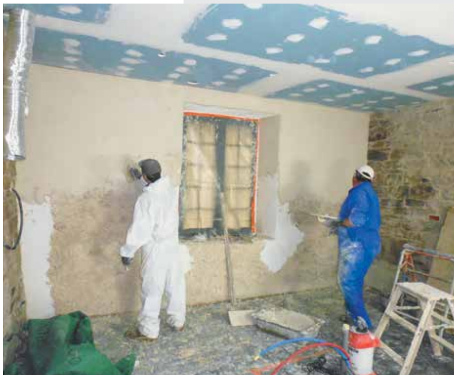
L'isolation des murs en chaux-chanvre : la garantie d'un isolant respectueux des échanges hygrométriques des murs en pierre.
